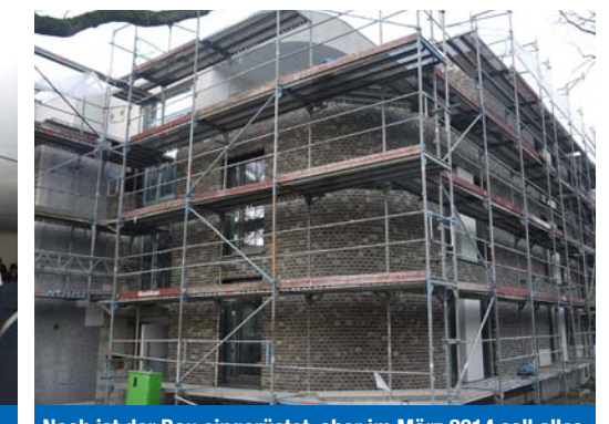
Noch ist der Bau eingerüstet, aber im März 2014 soll alles fertig sein
